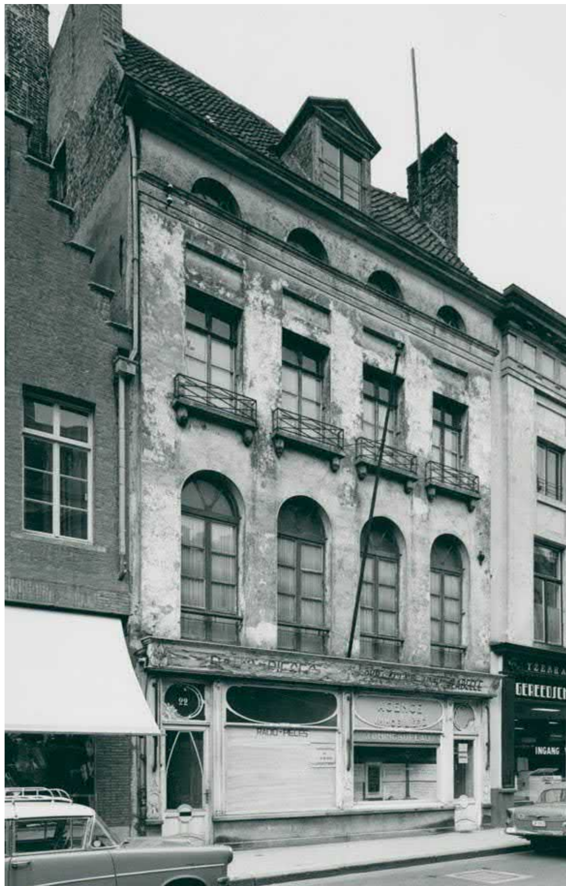
Het gesloopte huis in de Geldmuntstraat 22 (foto H. Vanhaelewyn – Westlandrica, Provinciale Erfgoedbibliotheek).
